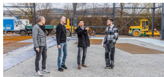
Im September 2023 ist der Umzug von DELO ins benachbarte Hechingen geplant. Die Bauarbeiten sind in vollem Gange. Mit einer bebauten Fläche von 2.000 Quadratmetern wird er damit die Produktion
