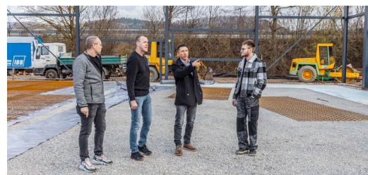
Im September 2023 ist der Umzug von DELO ins benachbarte Hechingen geplant. Die Bauarbeiten sind in vollem Gange. Mit einer bebauten Fläche
